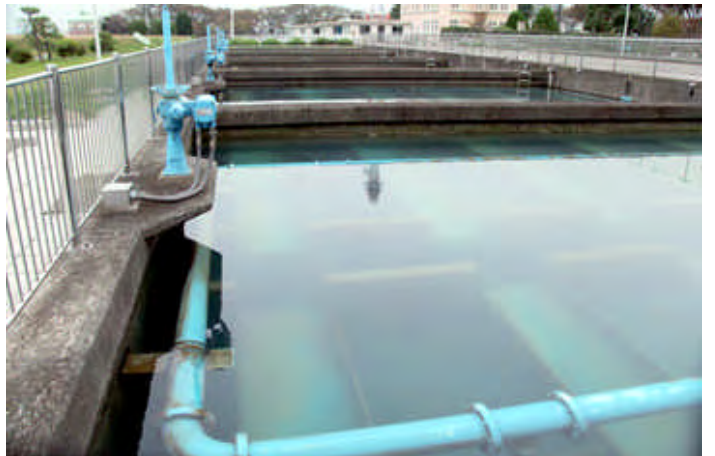
浄水場濾過池
