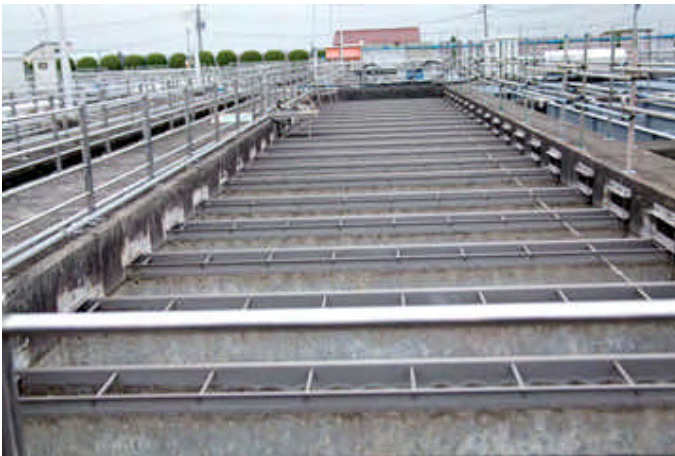
浄水場沈殿池
